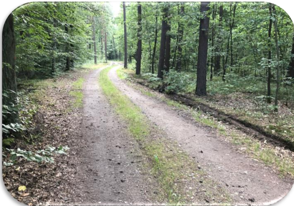
Fot. 2. Przekrój drogi na szlaku – istniejąca droga gruntowa umocniona kruszywem łamanym, miejscowe rowy odwadniające.
